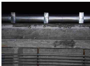
可視画像 ※多主桁コンクリート橋張り出し部
